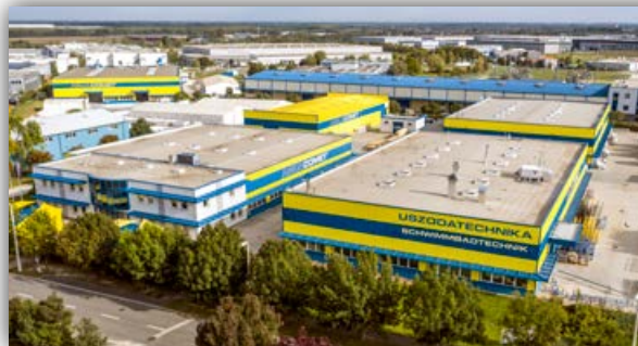
USINE D' AQUACOMET - PLANT Nr. 1
