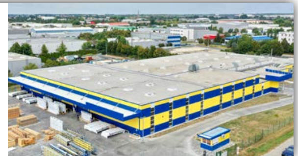
USINE D' AQUACOMET - PLANT Nr. 2
